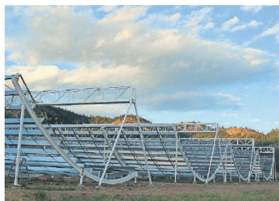
Die fest montierten Antennen des CHIME-Teleskops ähneln Halfpipes. Astronomen nutzen die Drehung der Erde, um den Himmel abzuscannen. MATEUS.A.FANDINO
